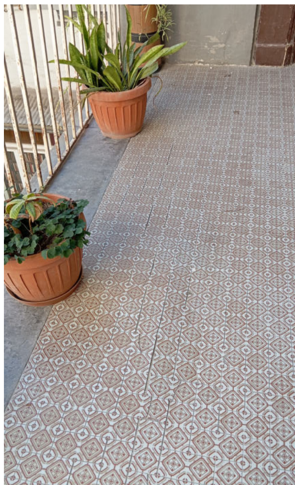
Foto 15 – Lesioni sul pianerottolo del vano scala
